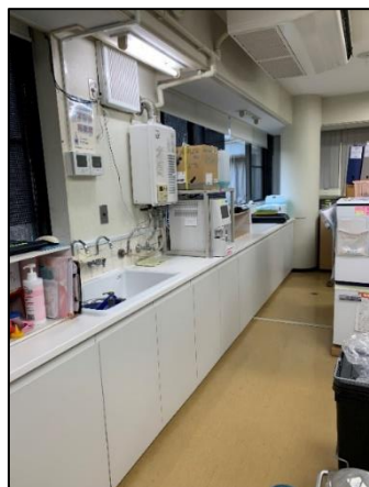
診察室 水回り改修
